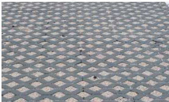
Dalle béton remplissage gravier
