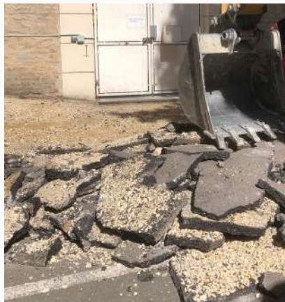
Désimperméabilisation des sols
